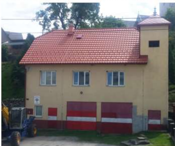
Dva rollovacie garážové dvere montované zvonku, kvôli dĺžke hasičských áut a dvere do skladu a veže.
